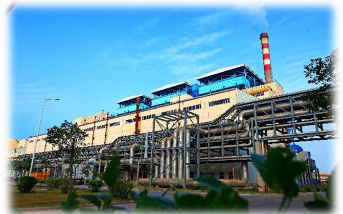
以上方法雖能為生產基地供電，但本公司也不能忽視熱電廠處理塔和焚化爐所帶來的空氣污染問題。有見及此，本公司投放資源更新多套除塵脫硫系統，將二氧化硫和粉塵排放達到國家超低排放標準。而且，鍋爐中的煙塵也透過吊膜及玻璃鋼等封閉和收集起來，及後利用生物除臭設備集中處理，絕不隨意棄置。本公司亦為熱電廠增設氨區超級稀氨器和進行油墨渣燃燒改造項目，期望能進一步減低污染物的排放。
